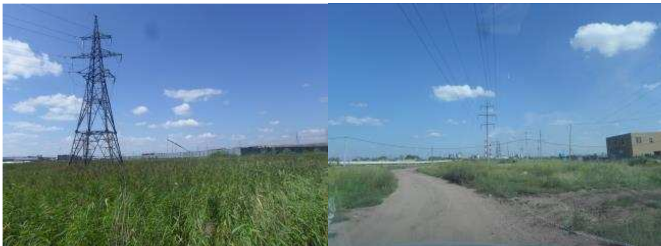
Рисунок 4-1 Фотографии с места строительства ВЛ 110 «АТЭЦ2-Промзона»
